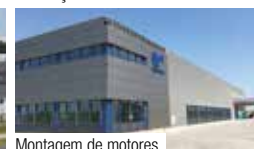
Montagem de motores
