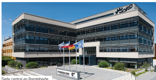
Sede central en Bargteheide
