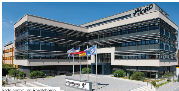
Sede central en Bargteheide
