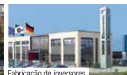
Fabricação de inversores
