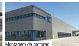
Montagem de motores
