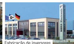
Fabricação de inversores
