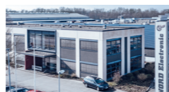
Fabricação de inversores
