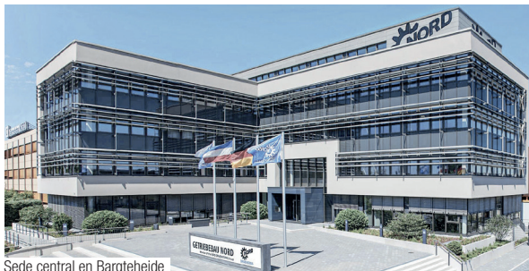
Sede central en Bargteheide
