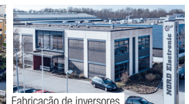
Fabricação de inversores
