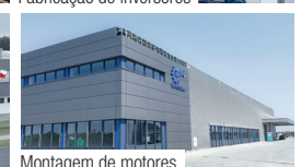
Montagem de motores
