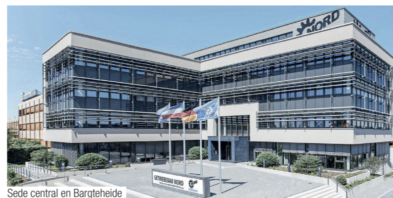
Sede central en Bargteheide
