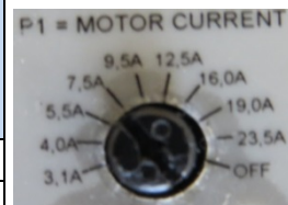
Рисунок: P1 пускового устройства двигателя на 7,5 кВт
